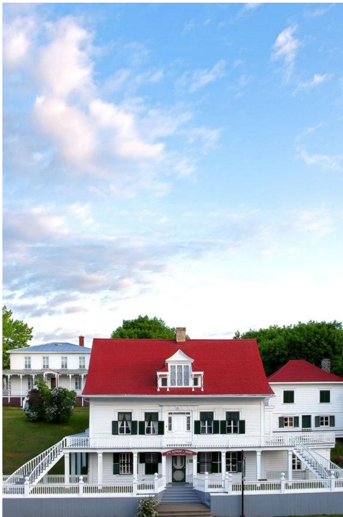
Restauration de la toiture de la Maison Chapais, Saint-Denis-De La Bouteillerie
