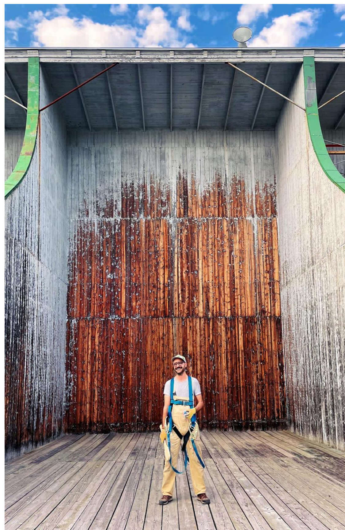
Le projet de revalorisation de la structure de balle au mur du Collège Sainte-Anne-de-La-Pocatière avec Vrille art actuel et Nicolas Laverdière
