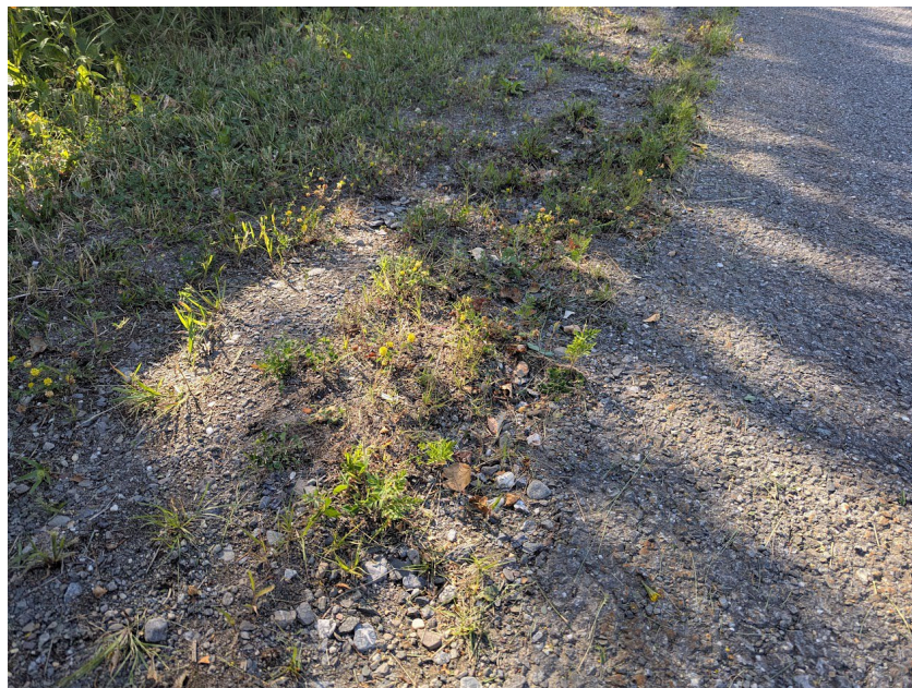
Route de la Station_026 – Saint-Éloi
