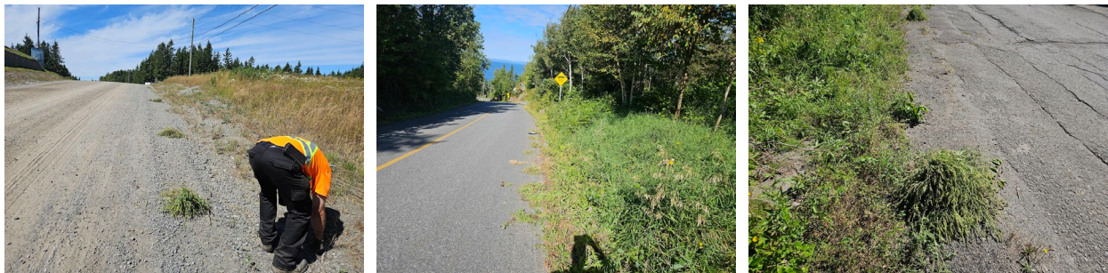
Figure 5. Travaux d'arrachage supervisés : 1) Saint-Mathieu-de Rioux, 2) Saint-Simon-de-Rimouski, 3) Notre-Dame-des-Neiges
